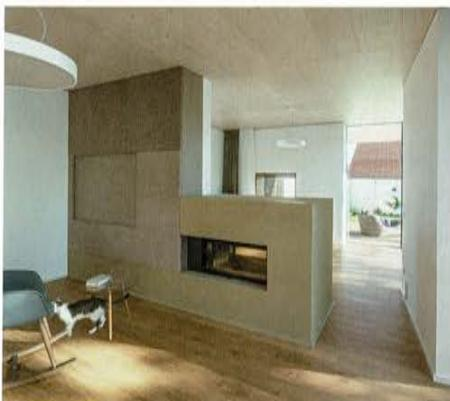
in Holz ausgeführt; Wände und Decken teilweise mit Lehm verputzt. Die eigentliche Tragstruktur wurde als Massivbauweise in Stahlbeton und Ziegel errichtet. Das Dach ist eine Massivholzdecke, die umlaufend im Innenhof auskragt und somit im Sommer für Verschattung in den Innenräumen sorgt. Im Winter hingegen ermöglicht die Ausrichtung der großen Glasflächen die Nutzung der solaren Sonnenstrahlen.
